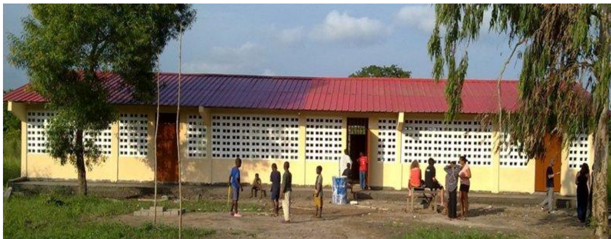
Photo été 2011 - Bâtiment de trois classes à la fin du projet.
